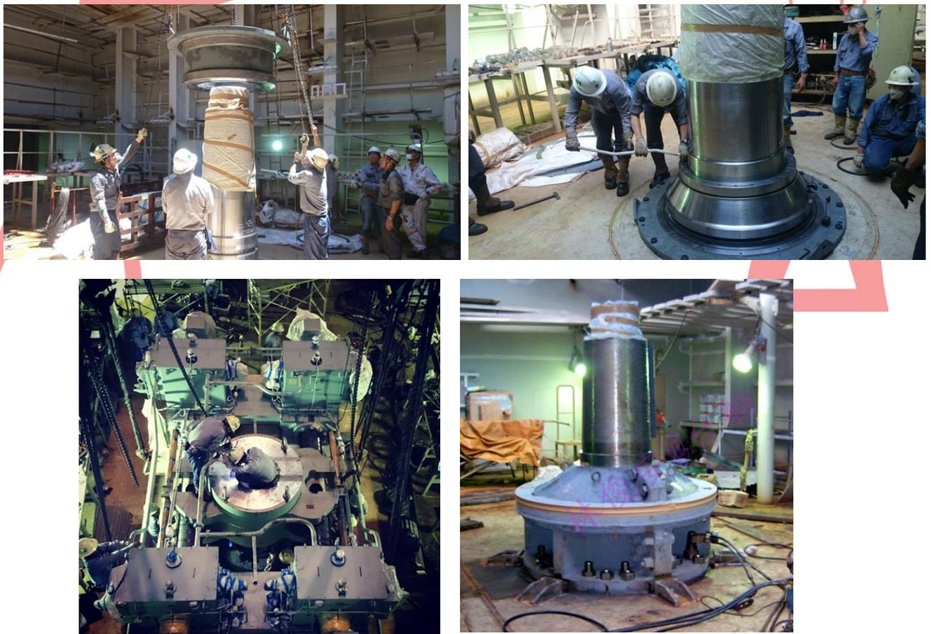
圖 8 舵機安裝施工項目實照
